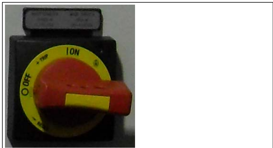
Figura 7: Apparecchiatura di rete e dispositivo di esclusione
